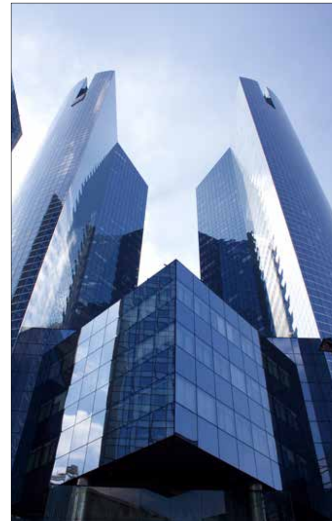
Société Générale Headquarters, Paris.
